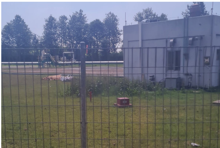
Bangunan kantor/basecamp sebagai objek pemeliharaan.
